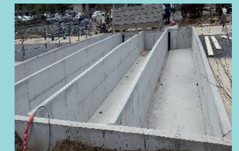
Dispositif d'évaluation de matériaux alternatifs en technique routière : planches routières instrumentées
